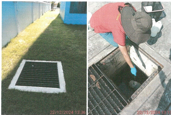
รูปภาพที่ 2.53 ตะแกรงครอบรูท่อระบายน้ำ
