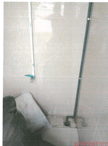
รูปภาพที่ 2.29 ท่อระบายน้ำเสียจากห้องพักขยะ
